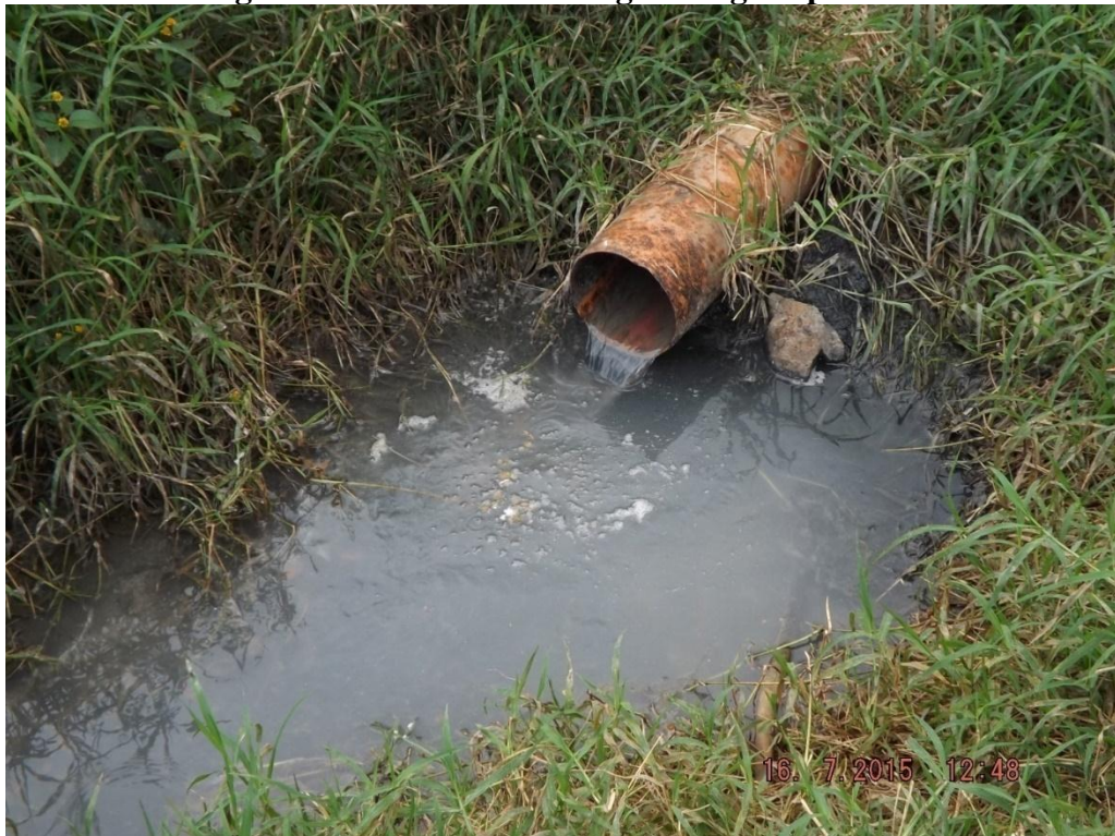
Figura 67: Rede mista de esgoto e águas pluvias
