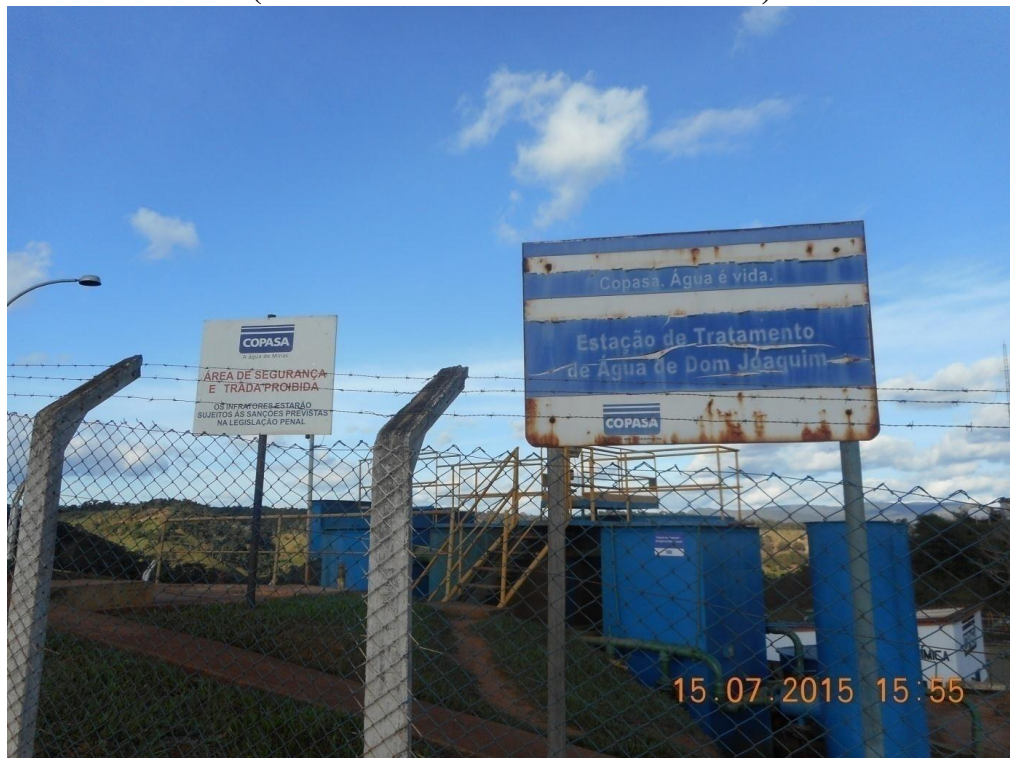
Figura 32: Visão frontal da ETA da sede de Dom Joaquim (Local: S 18°57'54.6" W 043°15'06.5")
