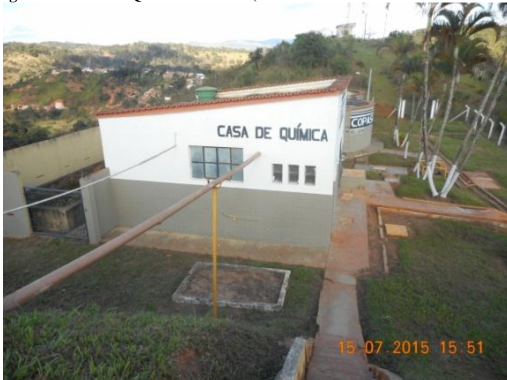
Figura 34: Casa de Química da ETA (Local: S 18°57'54.6'' W 043°15'06.5'')
