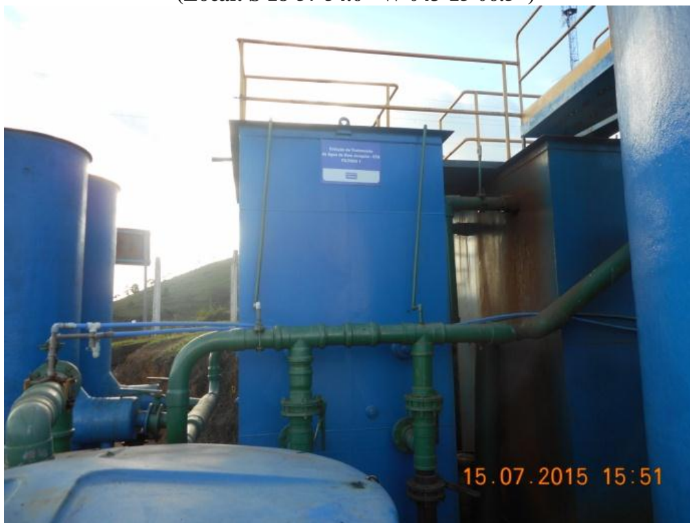
Figura 37: Vista parcial da estrutura dos filtros (Local: S 18°57'54.6" W 043°15'06.5")
