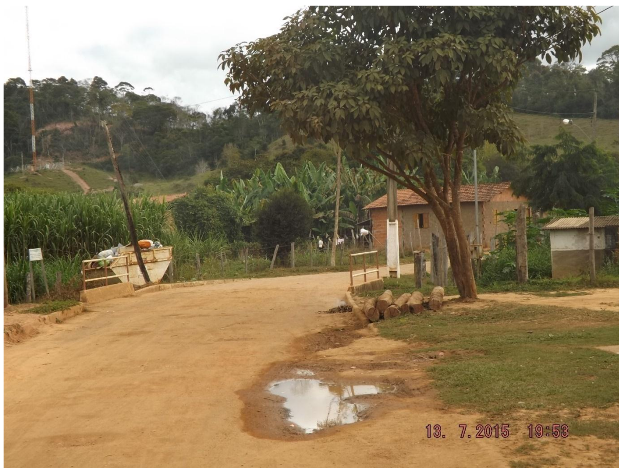
Figura 64: Rua contribuindo com carga de sedimentos obstruindo a pouca drenagem existente (ineficiente) no município.
