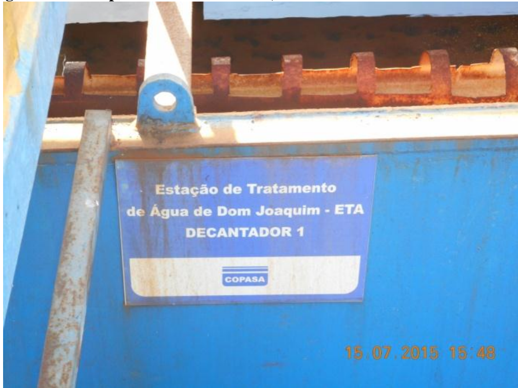
Figura 36: Vista parcial do decantador (Local: S 18°57'54.6'' W 043°15'06.5'')
