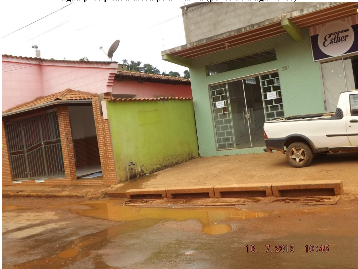
Figura 63: Área na cidade de Dom Joaquim com drenagem (ineficiente) pluvial onde água precipitada escoar pela mesma (ponto de alagamento).
