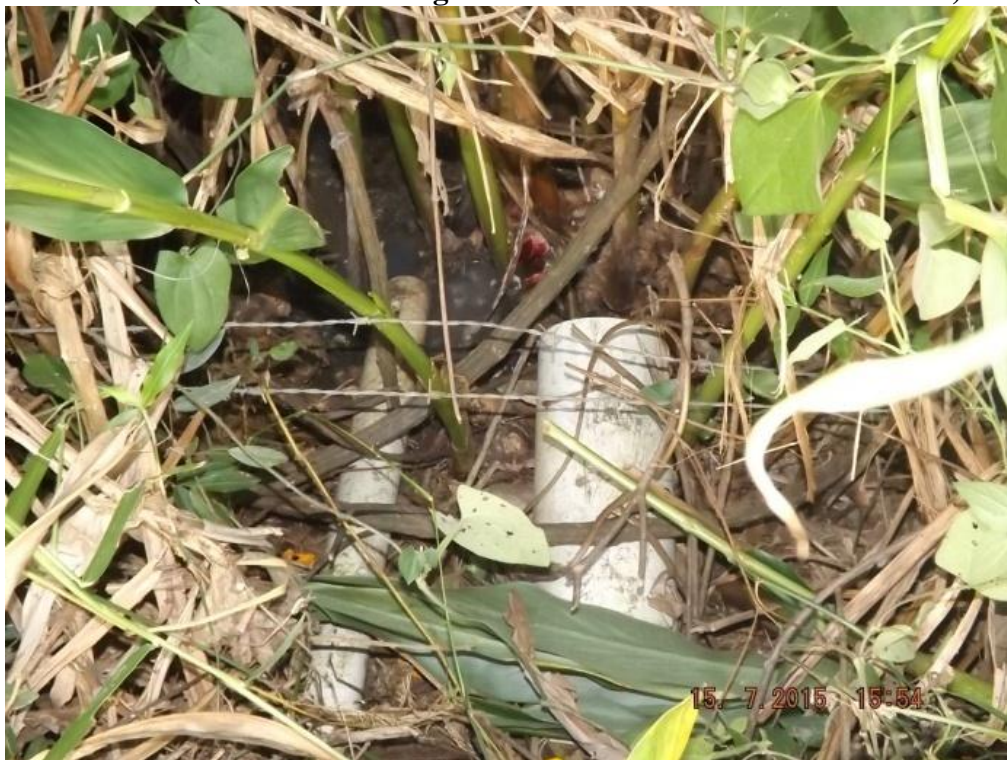
Figura 56: Lançamento de esgoto doméstico in natura no final da escola da comunidade Sesmaria (Coordenada Geográfica: S 18°55'08.3" W 043°13'10.1")
