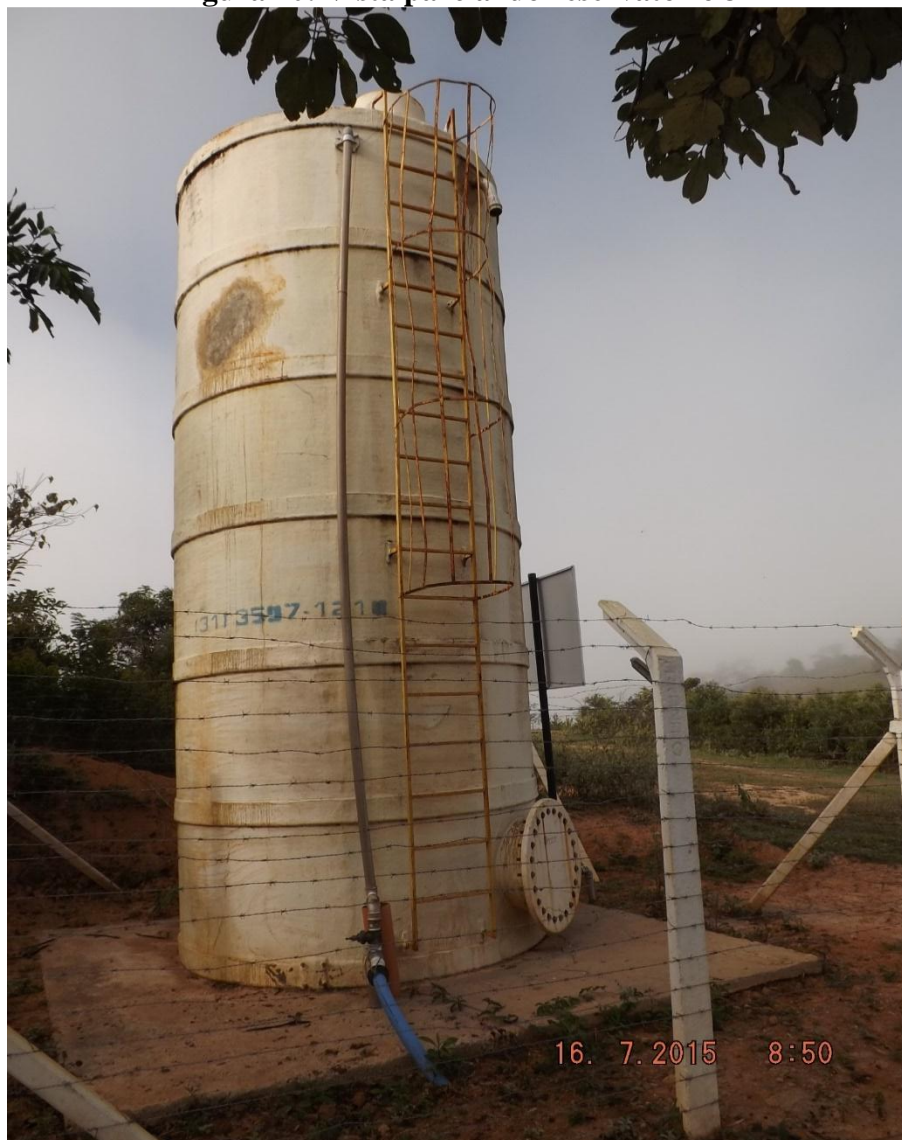
Figura 40: Vista parcial do reservatório 3
