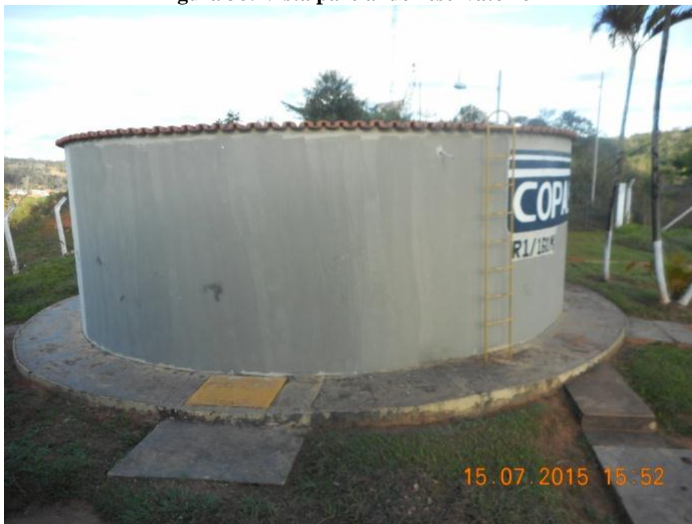
Figura 38: Vista parcial do reservatório 1
